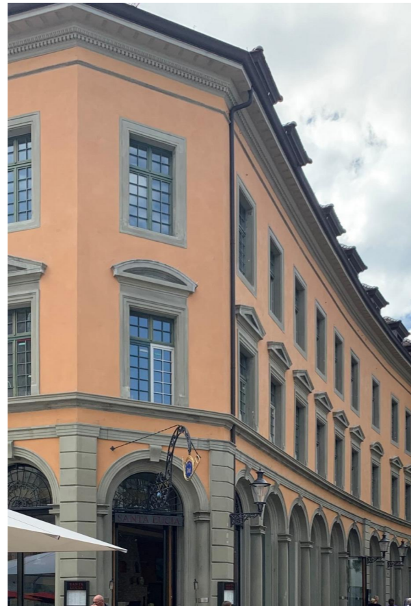
ECKE SCHWERTSTRASSE - FRONWAGPLATZ
