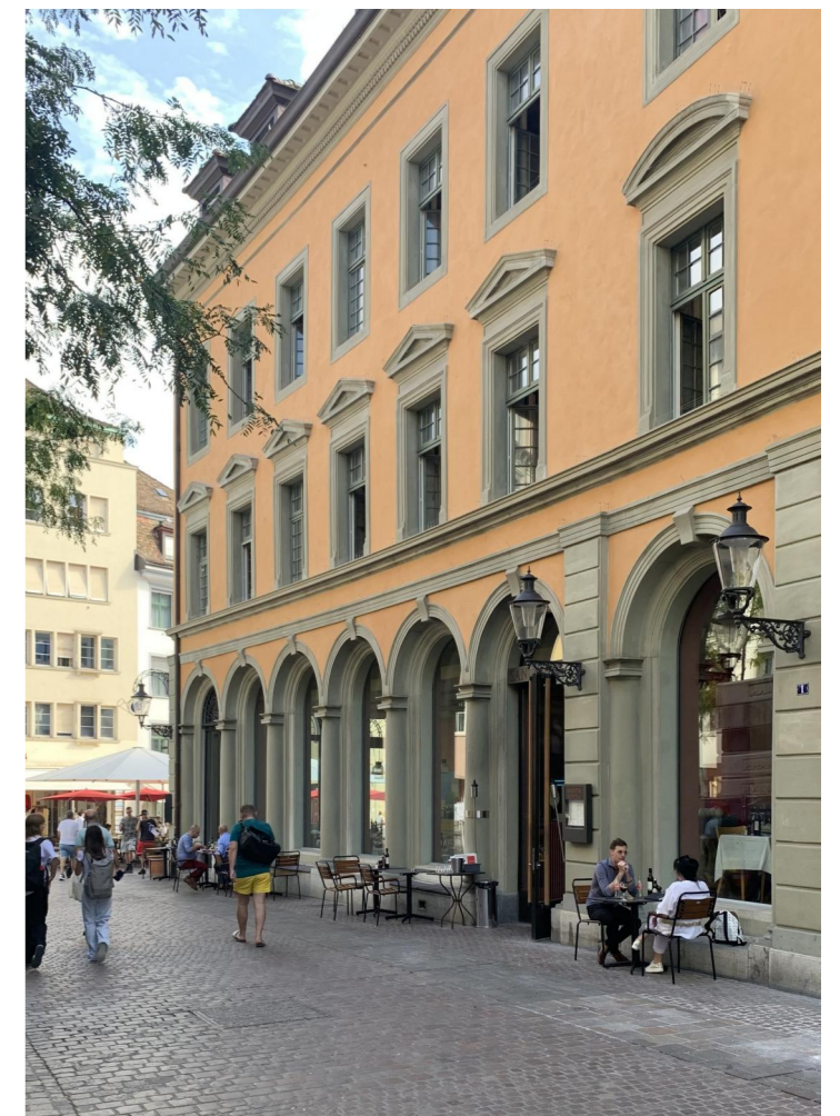
SCHWERTSTRASSE NACH FERTIGGESTELLTER AUSSENSANIERUNG
